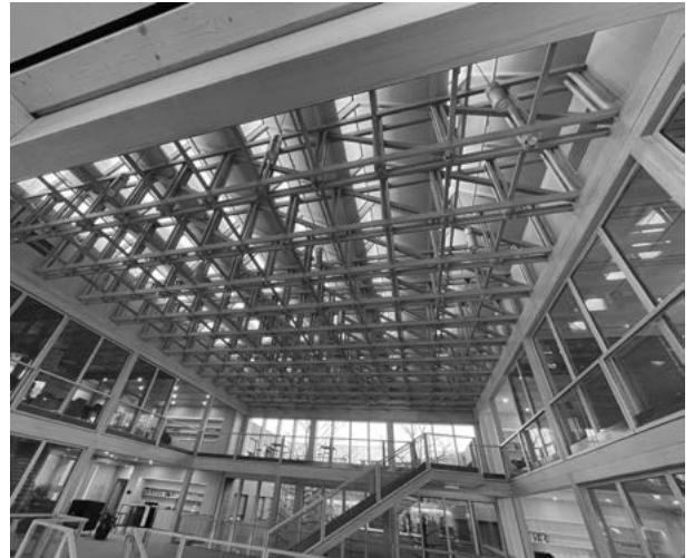
Das eindruckliche Bürogebäude der ERNE AG Holzbau (Bild: ETH Zürich)
